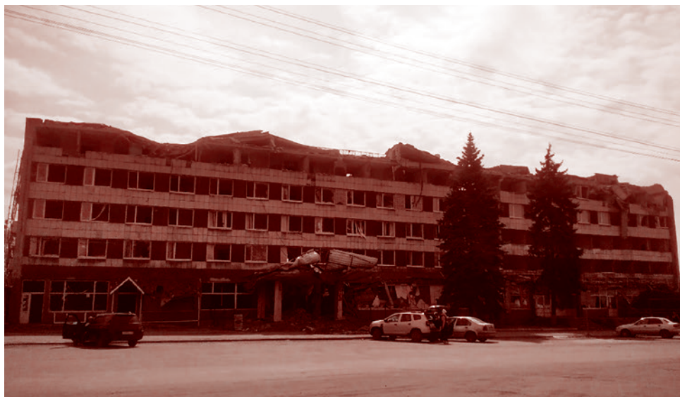
Разрушенное здание в Луганске
