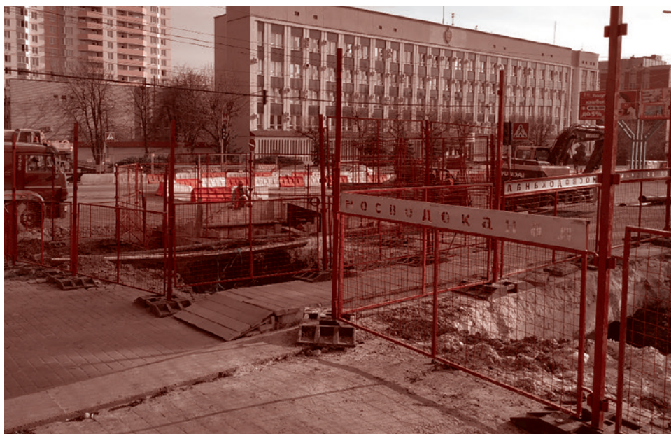
Ограждения ремонтных работ от коммунальной службы «Мосводоканал»
